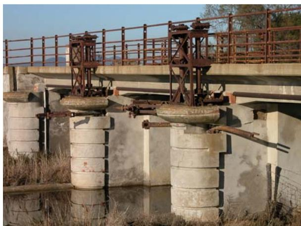
Particolare delle strutture per il movimento delle cateratte
