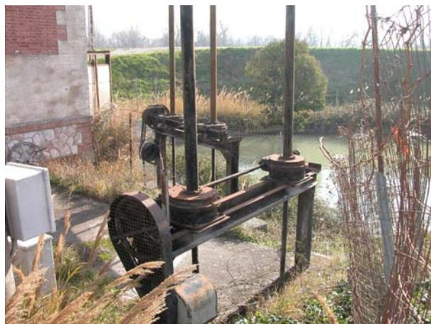
Ingranaggi per il movimento delle cateratte
