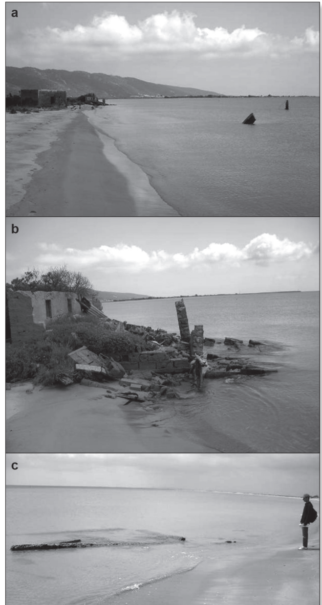
Fig. 6 – Témoins de l'importance de l'érosion du lido dans le secteur compris entre le port de pêche et l'ancien Boughaz
